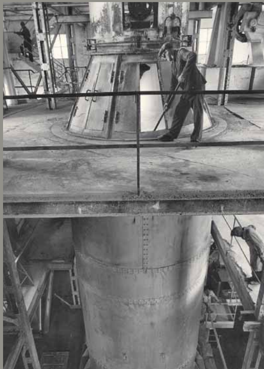
Arbeiter auf der GICHTBÜHNE DES SCHACHTOFENS beim Abstoßen von Anbackungen, 1952.
