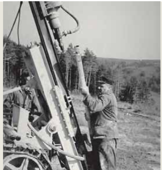
BOHRMASCHINE beim Erstellen von Bohrlöcher für eine Großbohrloch- sprengung, 1956.
