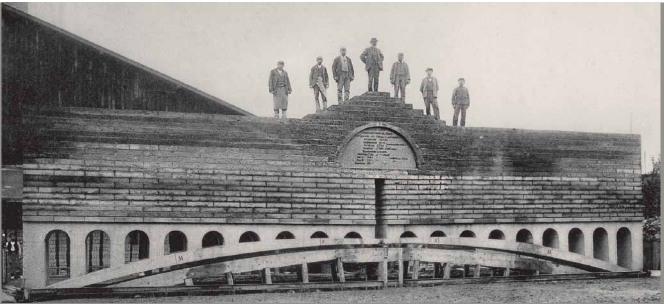
DREIGELENK-BETONPROBEBOGEN DER STUTTGARTER CEMENTFABRIK in Ehingen aus dem Jahr 1896 mit 20 m Spannweite und 1,42 m Höhe. Bei einer Belastung mit insgesamt 226 t traten Druckkräfte bis 3720 N/cm 2 und Zugkräfte bis 1275 N/cm 2 auf.
