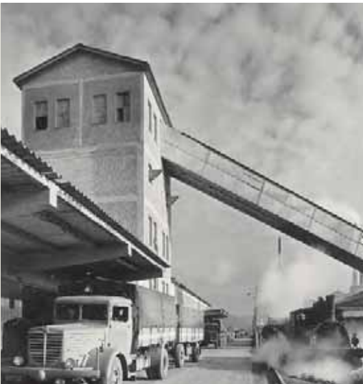
NEUE PACKEREI, Zement wird zunehmend mit LKWs transportiert, 1958.
