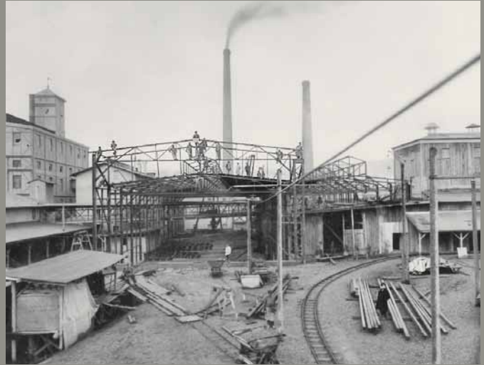
ERRICHTUNG DES NEUEN OFENGEBÄUDES , 1928.
