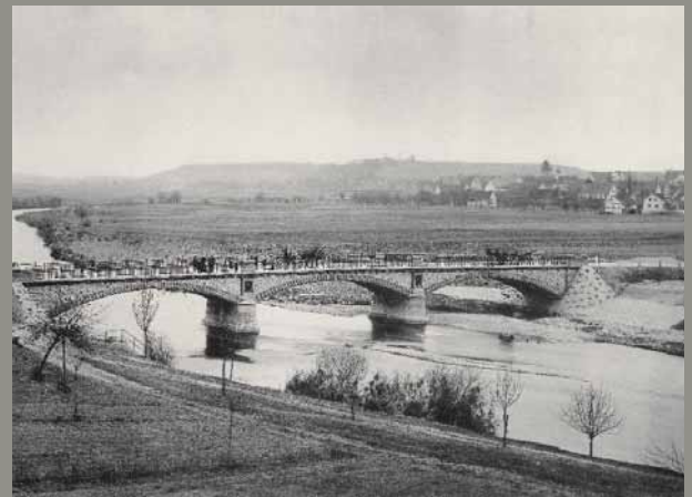
BETONBRÜCKE ÜBER DIE DONAU IN BERG BEI EHINGEN. Drei Öffnungen mit 21, 20 und 21 m Lichtweite. Pfeil 2,0 m. Erbaut 1897/98.
