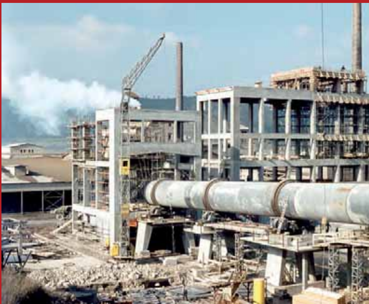
Neuer SCHWEBEGAS-WÄRMETAUSCHEROFEN im Bau, 1971.
