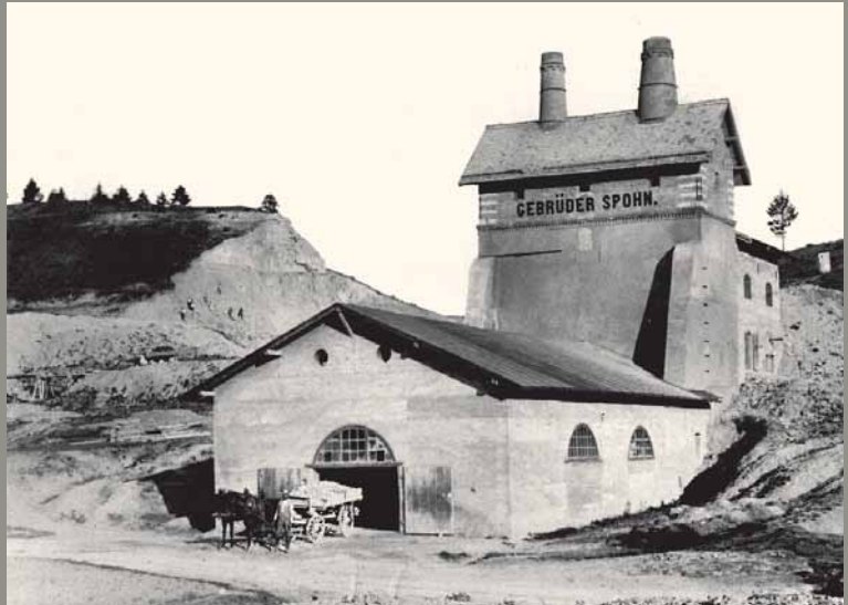
DOPPELSCHACHTOFEN DER ZEMENTFABRIK ALLMENDINGEN der Gebrüder Spohn am Hausener Berg, erbaut 1882, abgerissen 1925, ca. 1890
