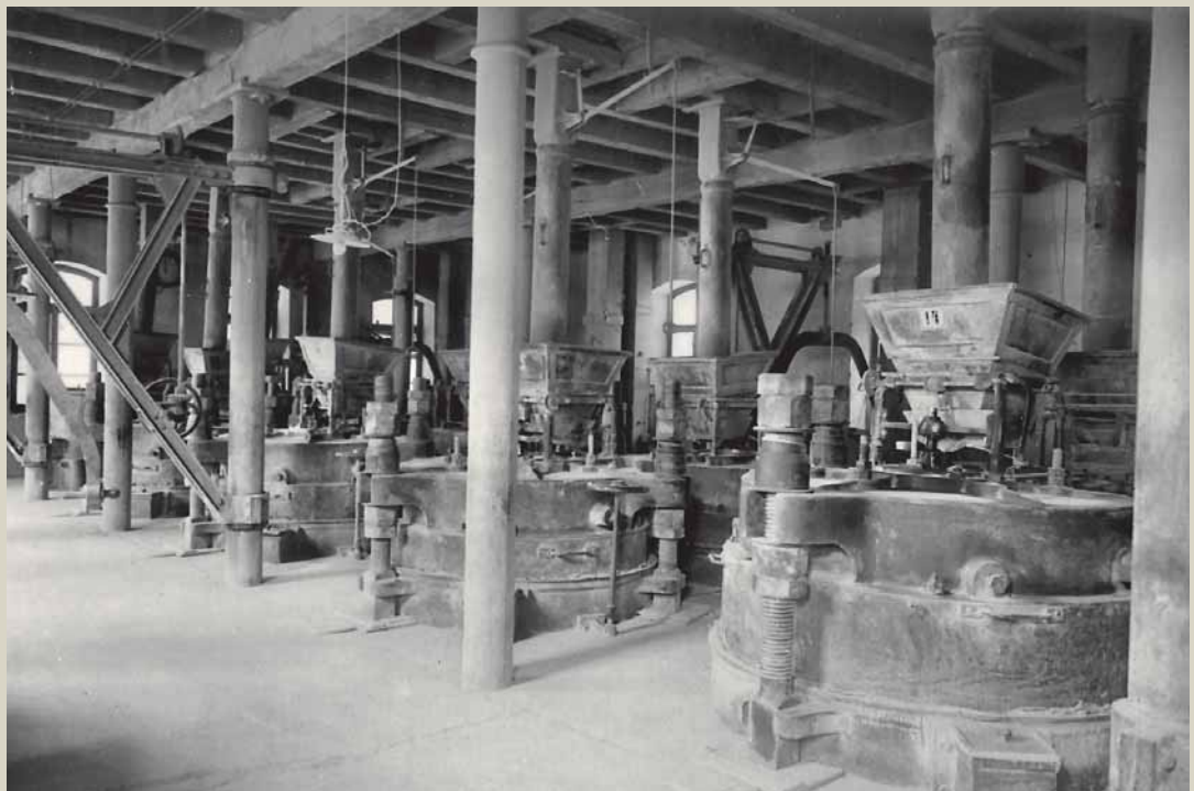
ALTE UNTERLÄUFERMAHLGÄNGE , wie sie im 19. Jh. auch in Getreidemühlen eingesetzt wurden, ca. 1925
