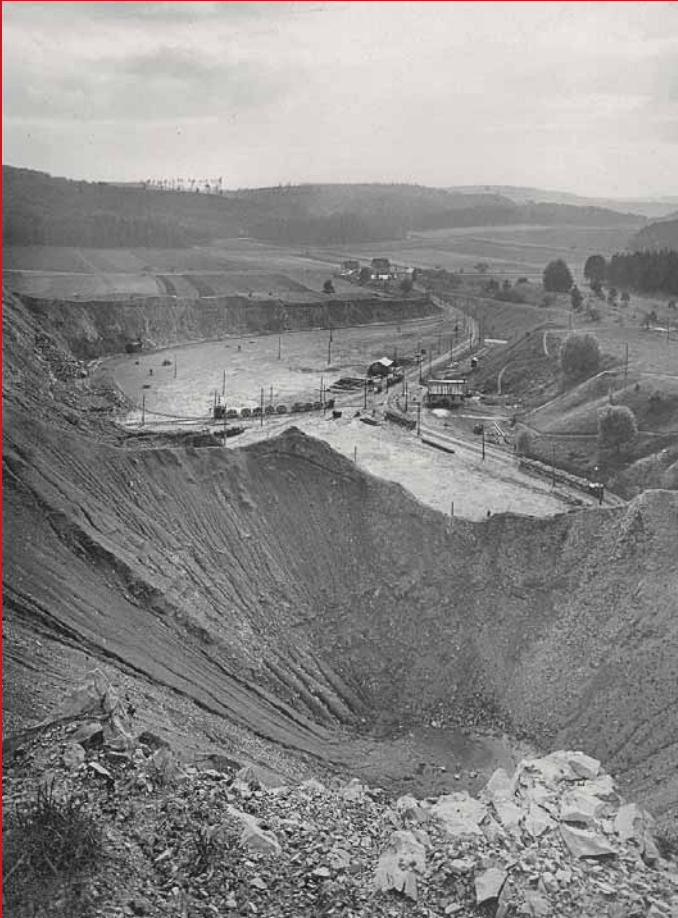
Im Vordergrund ein ROLLLOCH, im Hintergrund ist noch die alte Steinbruchlokomotive zu sehen, ca. 1930.
